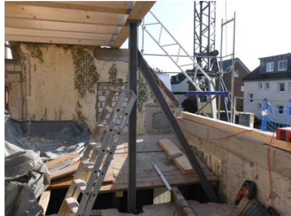
Stahlstütze | Stahlstrebe als Ersatz für unterdimensionierte Teile des alten Dachstuhls
