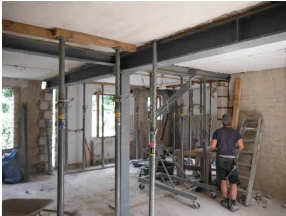
Stahlstütze | Stahlträger als Ersatz für tragende Innenwände Stahlstütze für neue Fenster- und Türöffnungen
