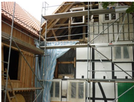
Instandsetzungsmaßnahmen am Fachwerk Restauratorische Zimmererarbeiten
