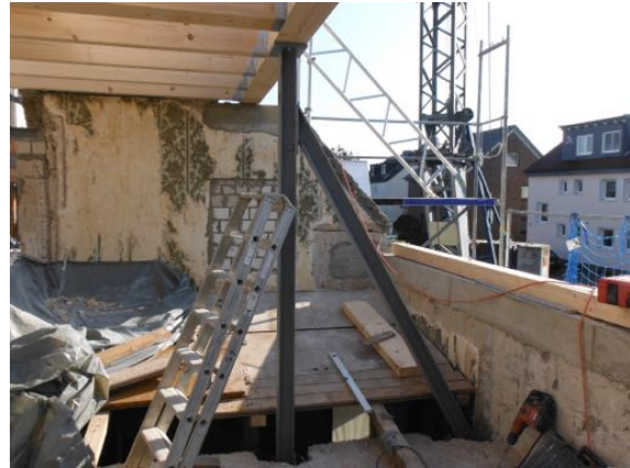
Stahlstütze | Stahlstrebe als Ersatz für unterdimensionierte Teile des alten Dachstuhl
