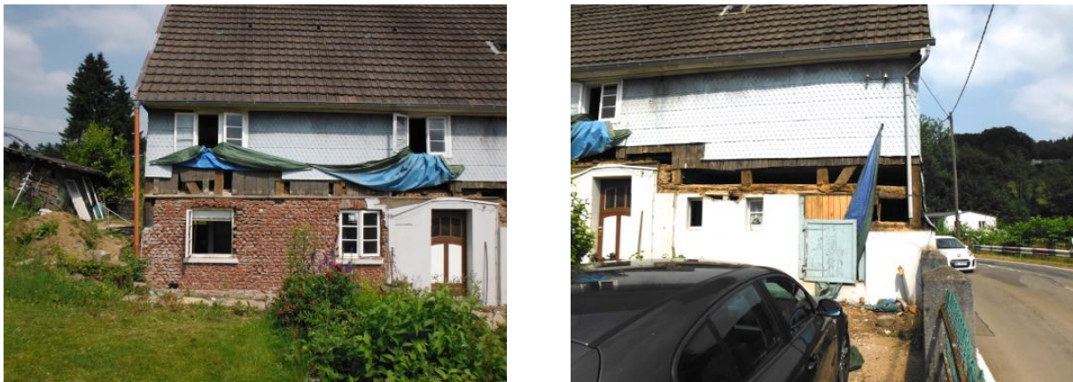
Ansicht Hofseite | Eingangsseite : Freilegung der Fachwerkkonstruktion | Begutachtung fehlender oder beschädigter Fachwerkteile
