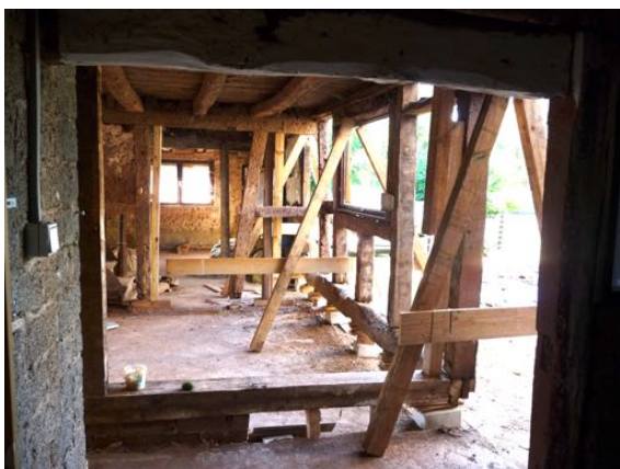
Austausch der Fußschwelle | Einzapfen alter Fachwerkstiele | Erneuerung des Sockelmauerwerks und der Bauwerksabdichtung
