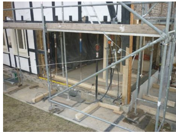
Instandsetzungsmaßnahmen am Fachwerk Restauratorische Zimmererarbeiten
