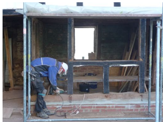
Austausch der Fußschwelle | Einzapfen alter Fachwerkstiele | Erneuerung des Sockelmauerwerks und der Bauwerksabdichtung
